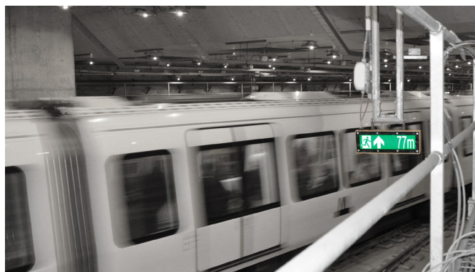
Metro monterad i Cityringen Nyhamn, Köpenhamns Metro.
